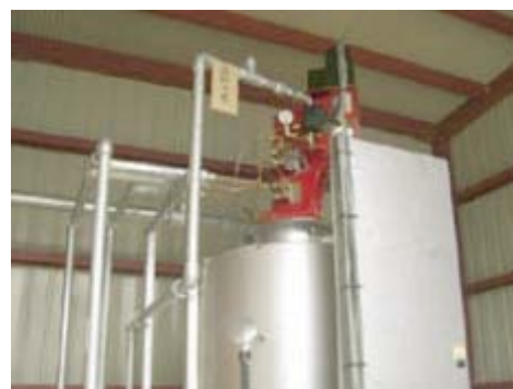
ボイラ上部 高燃焼装置・チャンバー部分
